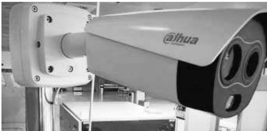
Las cámaras térmicas ya instaladas en el puerto de Algeciras.
