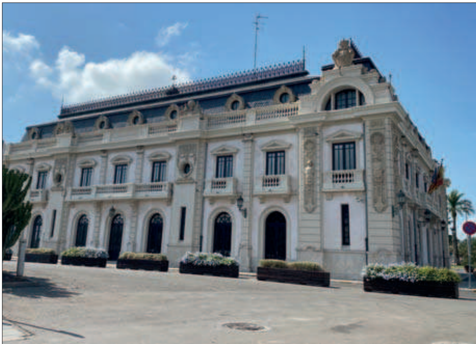
La APV recupera el Edificio del Reloj como centro cultural. (Foto VM)
