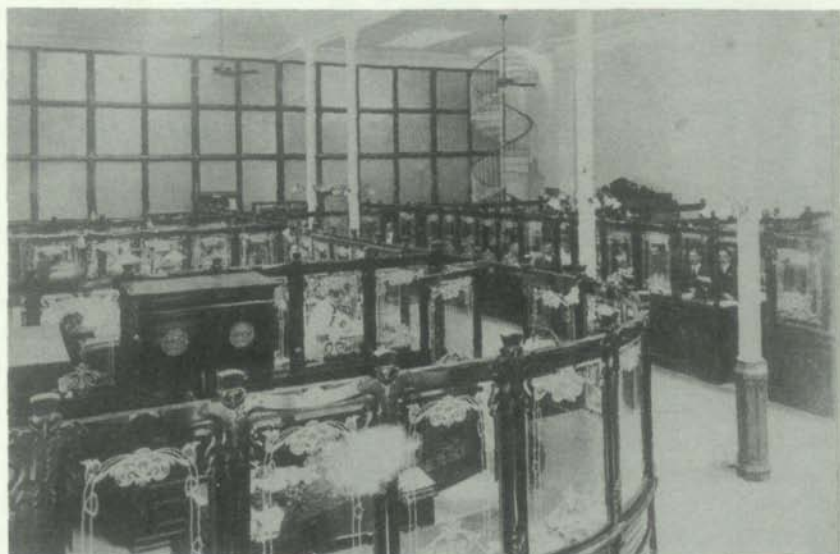
Oficinas de Grand Canary Coaling Company en el Puerto de La Luz, una muestra del estilo utilizado por los británicos para decorar los interiores de sus empresas mercantiles. Sus principales elementos eran maderas de caoba y cristales para mostradores y dependencias, y hierro forjado para las cajas fuertes; todo importado de Inglaterra.
