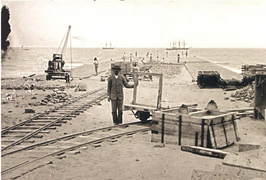
Figura 3: El inicio de las obras del Puerto de La Luz. Cámara Oficial de Comercio, Industria y Navegación de Las Palmas.
